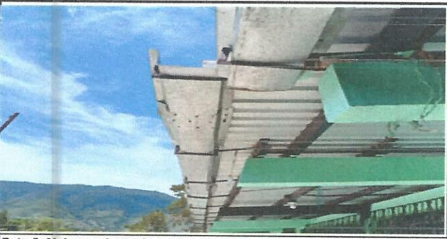
Foto 5: Mejoraamiento de caidas de agua.
