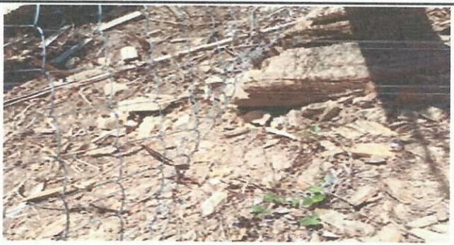
Foto 2: Meoramiento de muro perimetra-
